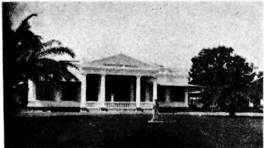
Edificio principal de la Estación Agronómica de Java. (Cortesía de la Unión Pan-Americana).
